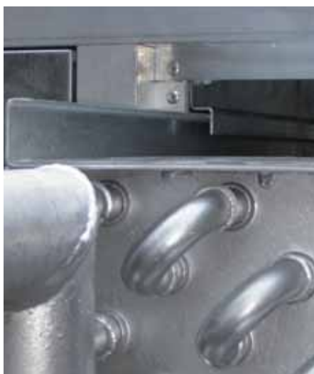
Particolare scorrimento batteria
