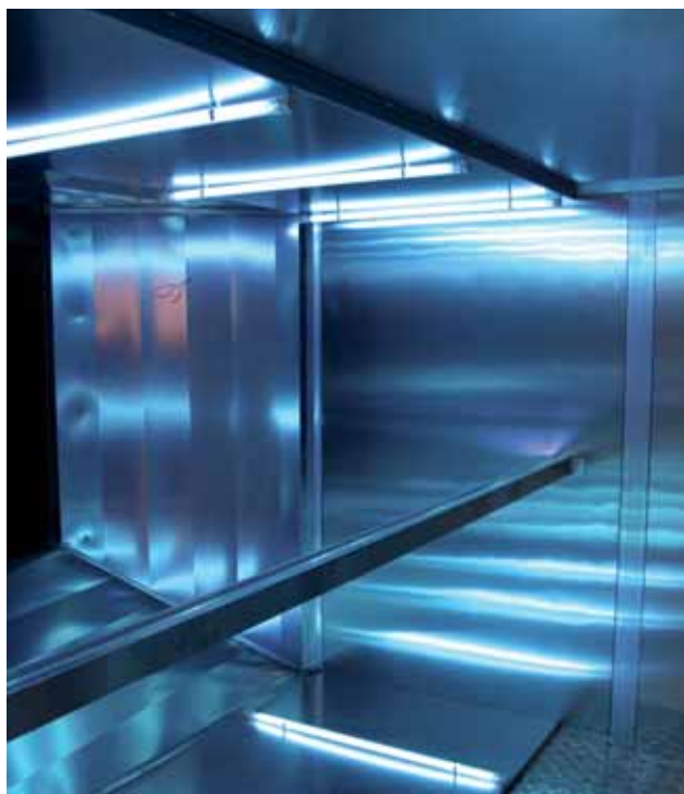
Plenum a mandata con lampade germicida
